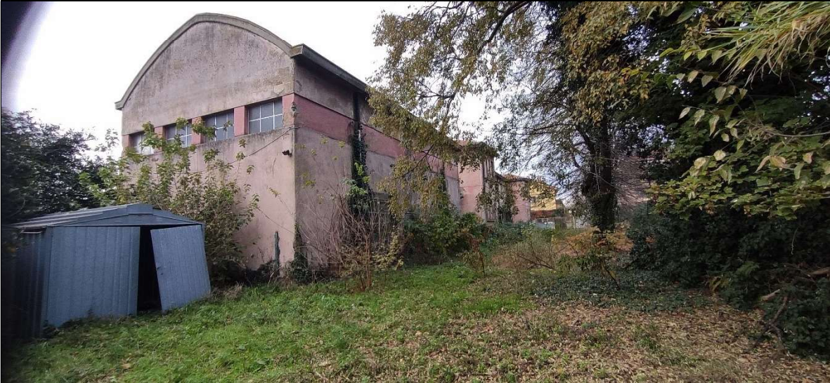
Ripresa dall'interno del lotto: in primo piano la facciata a sud della palestra
