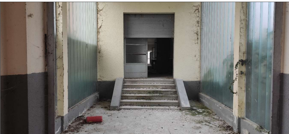
Collegamento tra l'edificio scolastico e la palestra: interno
