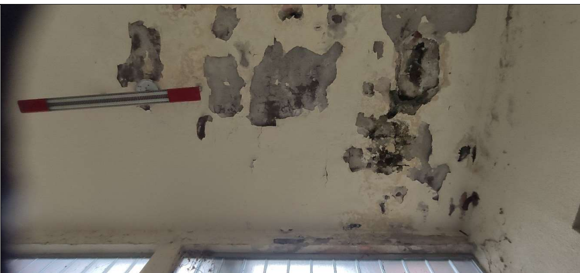
Collegamento tra l'edificio scolastico e la palestra: soffitto
