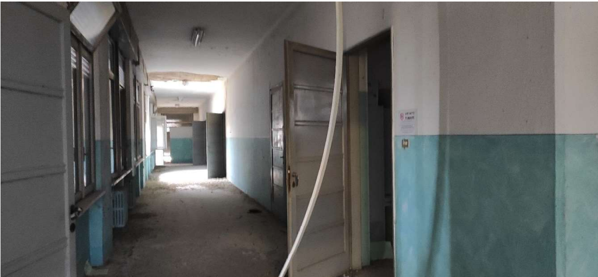
Interno dell'edificio scolastico: corridoio al piano primo
