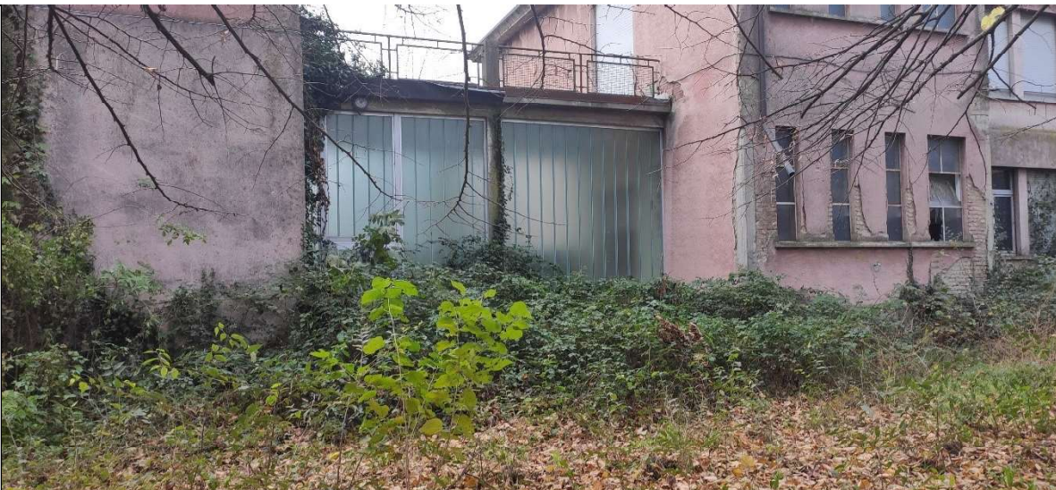
Ripresa dall'interno del lotto: in primo piano il collegamento tra l'edificio scolastico e la palestra
