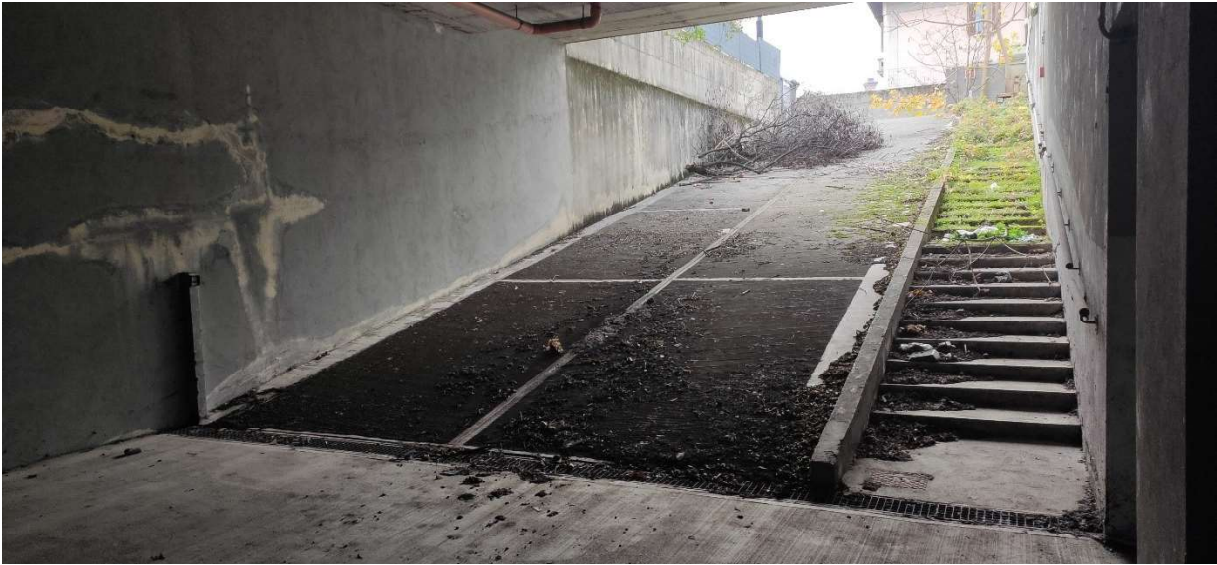
Scivolo di ingresso dal piano interrato dell' autorimessa
