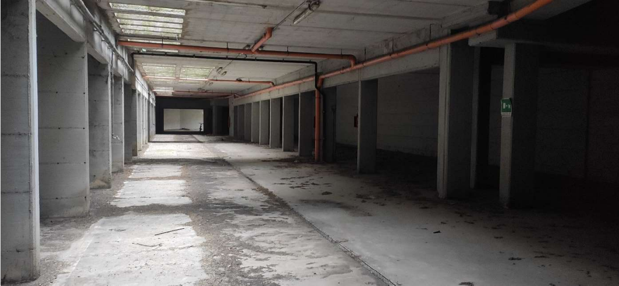
Ripresa dei posti auto lungo il lato interrato verso l'autorimessa condominiale delimitati solo dalle pilastrature modulari in c.a.
