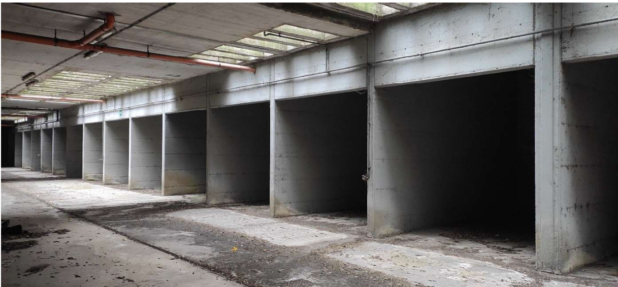
Ripresa dei posti auto lungo il lato interrato verso strada delimitati da setti murari in c.a.
