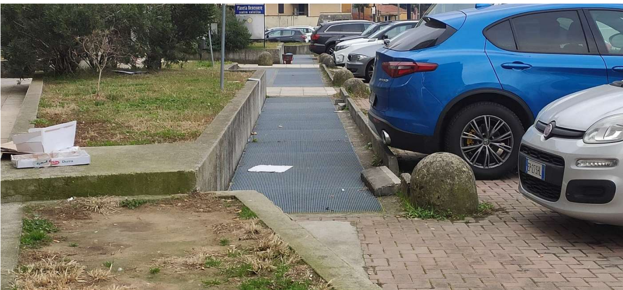
Ripresa de marciapiede e del grigliato in corrispondenza del corsello interrato dell'autorimessa
